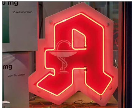
Bild 1: Leuchtröhrenanlage für Spannung bis AC 1000 V
