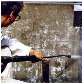
1.2 Fassadenreinigung mit dem Hochdruckreiniger
