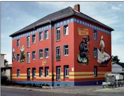
Bild 2: SARRASANI-Haus in Radebeul bei Dresden
