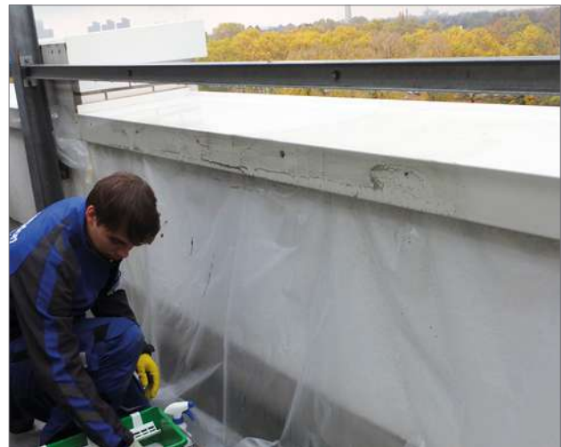
Bild 3: Sorgfältiger Umgang mit dem Eigentum des Kunden: Abhängen von Gebäudeteilen, um sie vor ablaufendem Schmutzwasser zu schützen
