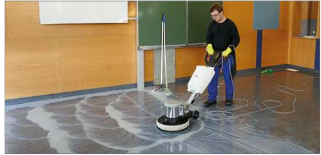
Bild 1: Klassische Nassgrundreinigung eines PVC-Belages
