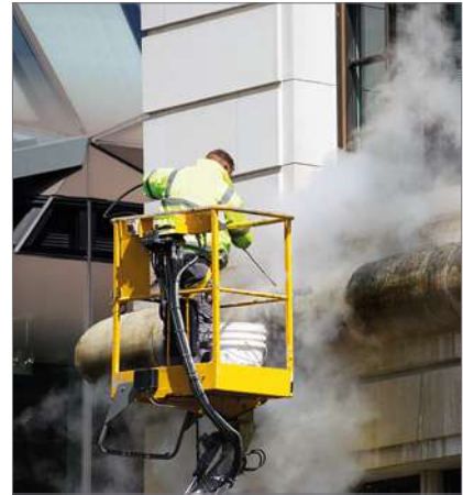
Bild 1: Beispiel aus Tätigkeitsspektrum: Fassadenreinigung
