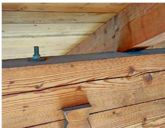
Bild 2: Anschluss Sparren-Pfette
