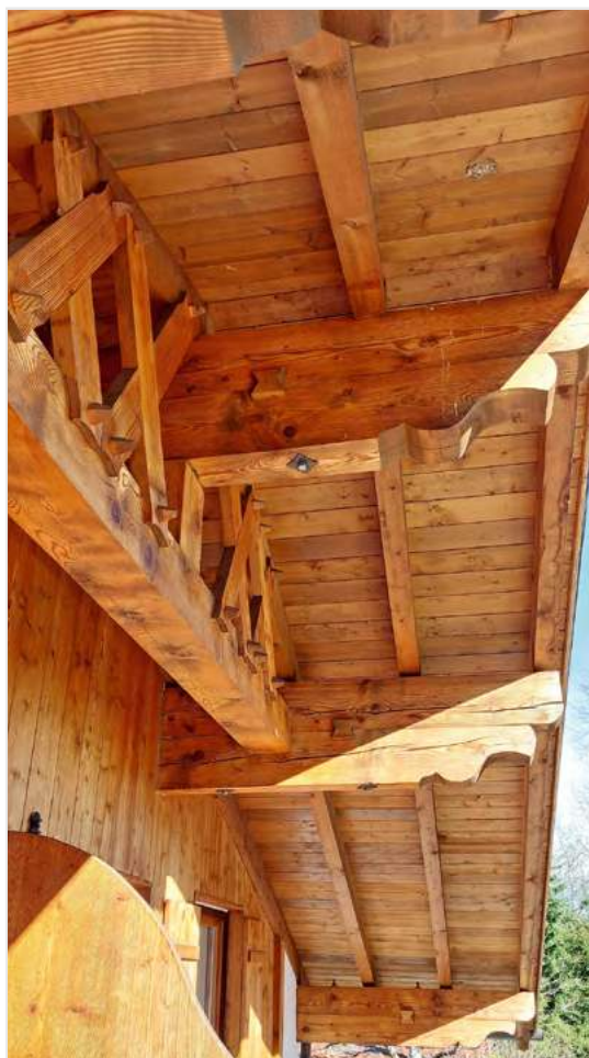
Bild 3: Zimmermannsmäßige Holzbauweise
