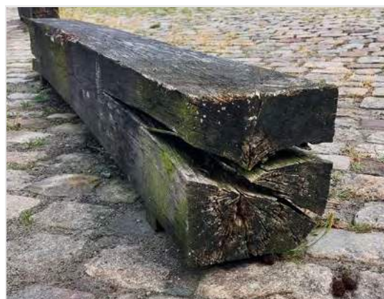
Bild 4: Holzverformungen durch Feuchteinfluss
