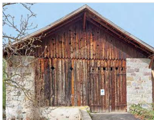
Bild 2: Witterungsbedingte Verfärbung
