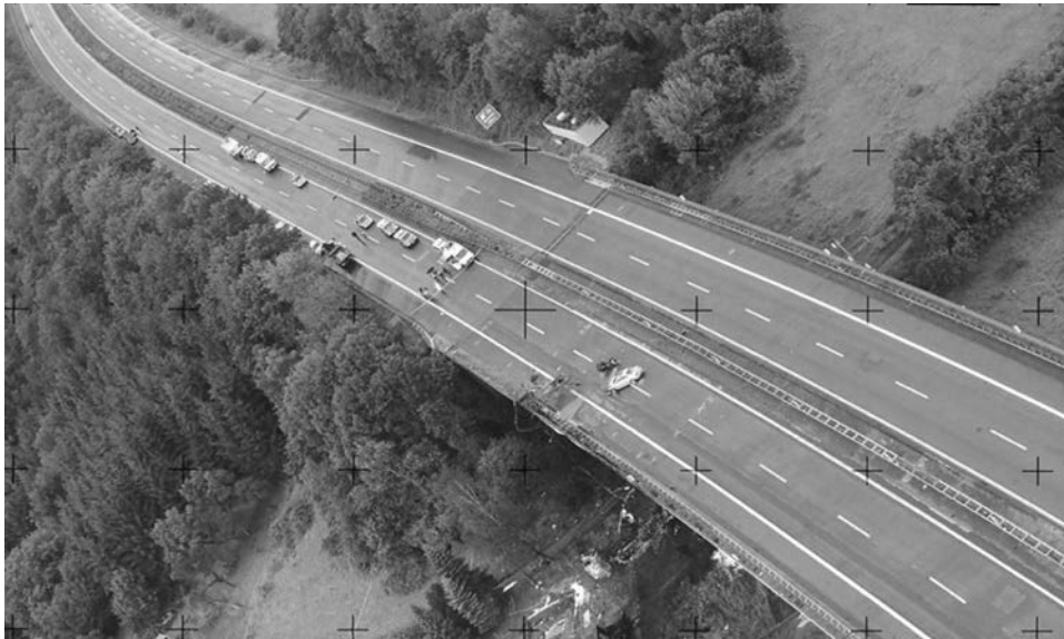
Bildquelle: Der Wiehthalbrückenunfall (ibwiew.de)
