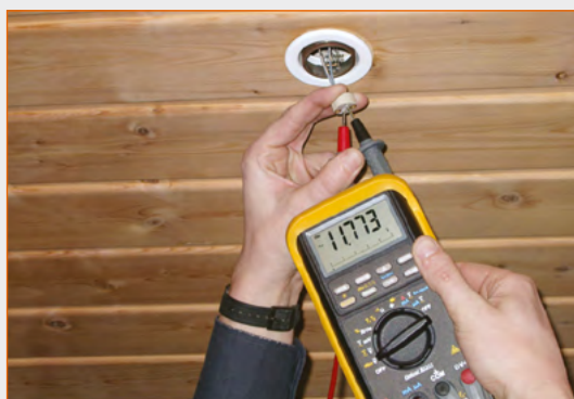
Bild 1: Spannungsmessung an einer Niedervolt-Halogen-Beleuchtungsanlage
