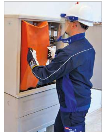
Bild 2: Abdecken spannungsfhrender Teile
