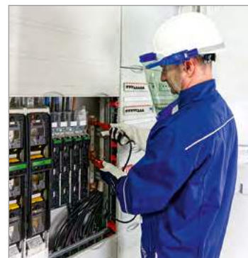
Bild 4: Überprüfen der Spannungsfreiheit mit einem zwei-poligen Spannungsprüfer
