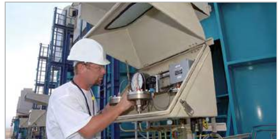
Bild 1: Prüfung einer Entsalzungsanlage von Meerwasser
