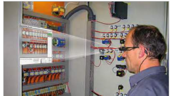
Bild 3: Elektroinstallation unterstützt durch AR (www.siemens.com)
