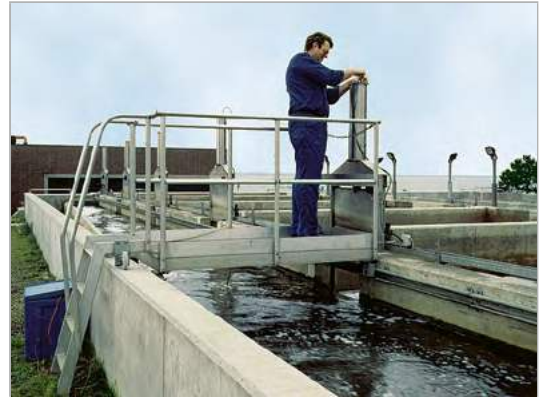
Bild 1: Fachkraft für Abwassertechnik bei der Arbeit
