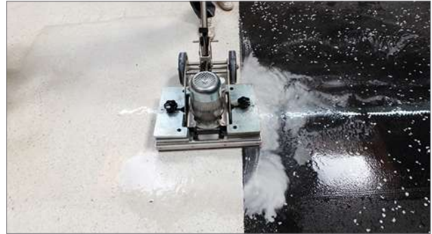
Bild 2: Test mit innovativer Reinigungsmaschine auf unterschiedlichen Terrazzobelägen
