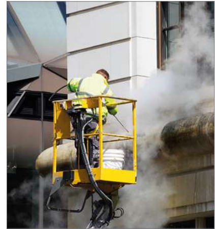
Bild 1: Beispiel aus Tätigkeitsspektrum: Fassadenreinigung
