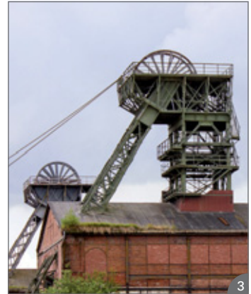
Schachtanlage Deutlich ist die Seilumschlingung, ca. 130^\circ , zu erkennen. © reeel – Fotolia.com
