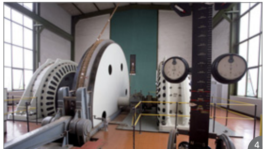
Maschinenhaus einer Schachtanlage Die große Seilscheibe ist vom Seil mit etwa 2 Windungen umschlungen. © ullsteinbild – imageBROKER / T. Frey
