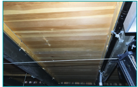
Bild 1: Aufbau des Bühnenbodens von unten
