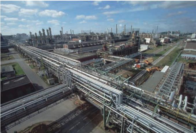
Abbildung 1-1 Rohrleitungen im Chemiepark Marl
