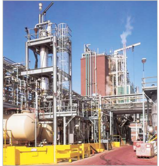
Bild 1: Blick in eine verfahrenstechnische Anlage zur Durchführung von Stoffwandlungsprozessen
