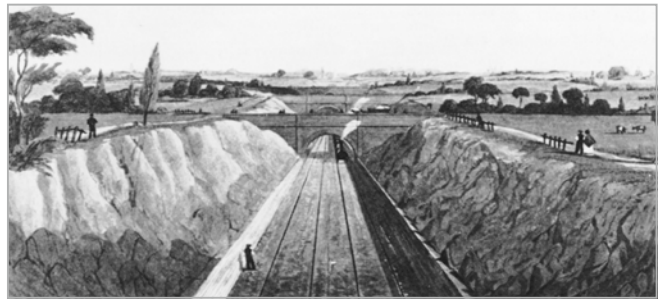
Bild 2: Liverpool–Manchester: Gestreckte Linienführung, flache Streckenneigung, zweigleisige Strecke, Personen- und Güterverkehr, schienenfreie Kreuzungen zwischen Eisenbahn und Straßen
