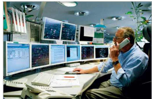
Bild 2: Netzleitzentrale (NLZ) Frankfurt am Main
